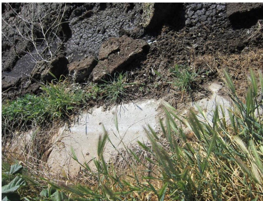
Fotografia 13: Pormenor do talude da 5ª lagoa de retenção.
