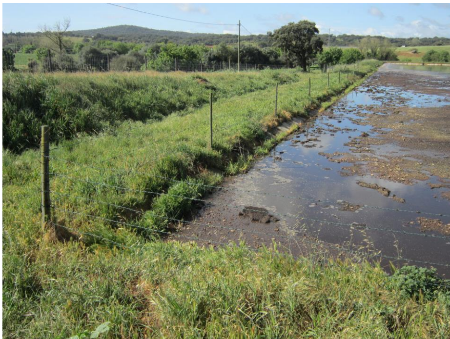
Fotografia 14: Pormenor da vedação junto à 4ª lagoa.
